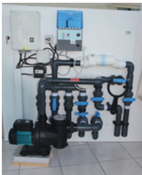
▲ Le Skimmer / filtre permet un « panneau » de filtration peu encombrant qui regroupe tout (Caron Piscines)
