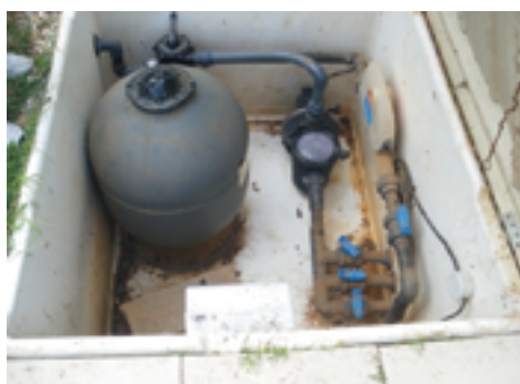
● Local ou coffret technique qui a pris l'eau. On aperçoit les traces de boue laissées par le passage de l'eau.
