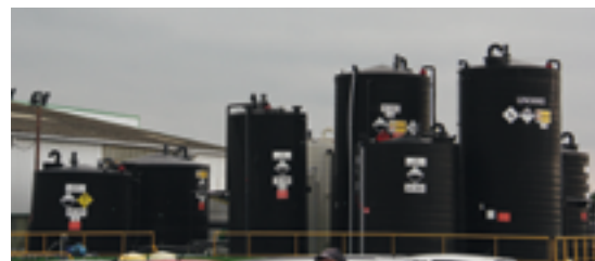
Site n°2 - Classé Seveso2
