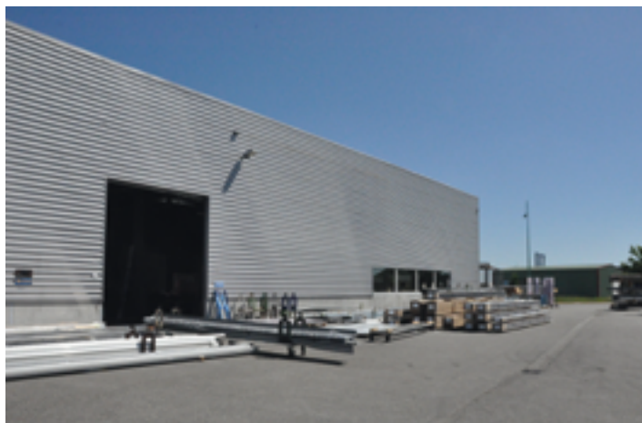
▲ Vue d'une partie de l'usine de fabrication Sheltom près de Toulouse. Sur un terrain de 7 000 m 2 avec aire de stockage pour abris « prêts à partir », 3 000 m 2 de bâtiment dont 500 m 2 consacrés aux bureaux
