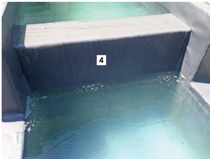
4 - lame d'eau ajoutant une surface d'échange thermique et donc une évaporation supplémentaire.
