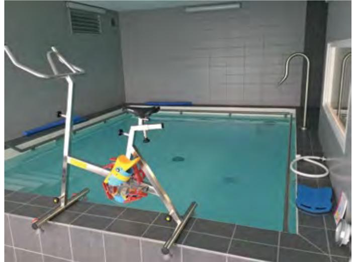
Un bassin très bien équipé avec barres inox périphériques, canon à eau, système balnéo (diffuseurs en fond de bassin et sur paroi), lance de massage et vélo. Côté technique, on remarque la grille de soufflage destinée à la déshumidification et au chauffage de l'ambiance.
