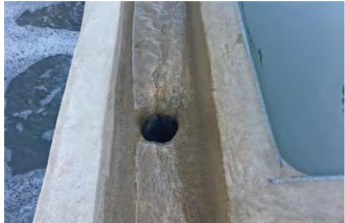
Lors d'un test de fuite avec un seau, une différence pouvant aller jusqu'à 3 mm ne signifie pas qu'il y a fuite.
