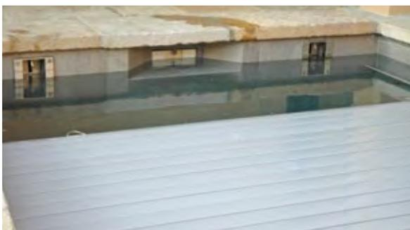
Aqua Cover a fait évoluer le système vers une version Cover Lock EVO II, redessinée pour s'adapter à des niveaux d'eau élevés. La nouvelle génération du dispositif de sécurité permet d'actionner la commande par une clé et informe l'utilisateur sur la position du volet, verrouillée ou déverrouillée, par un témoin lumineux.
