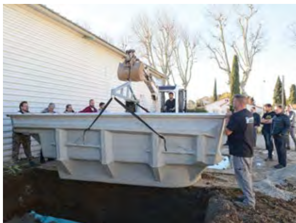
Pose de la coque
