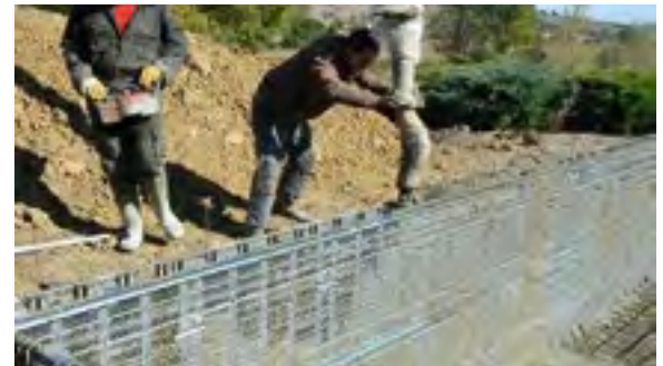
Coulage à la pompe
