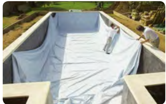
Mise en place d'un liner - MONDIAL PISCINE
