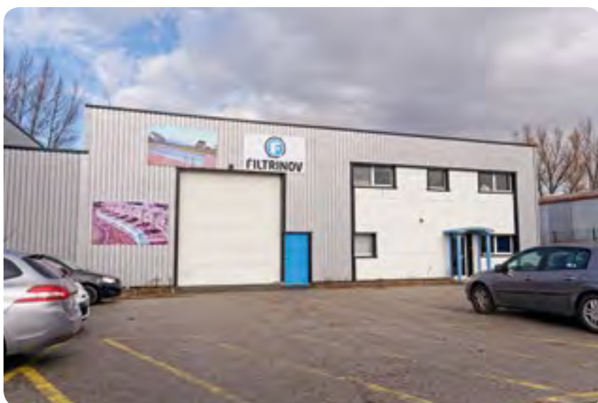
Les locaux de production Filtrinov à La Talaudière
