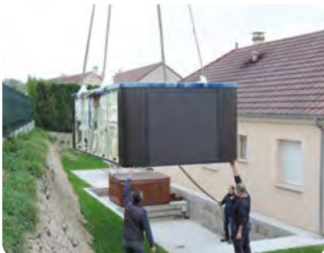
Installation du spa de nage Kilimanjaro
