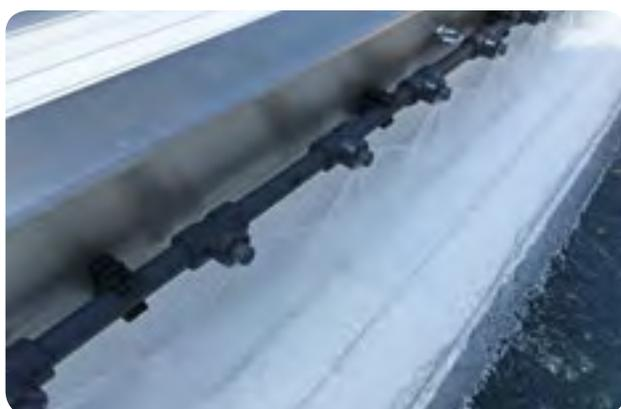
La rampe de nettoyage est installée en usine, sur la poutrelle du caillebotis et sur les montages intégrés en niche classique avec poutre et caillebotis.
