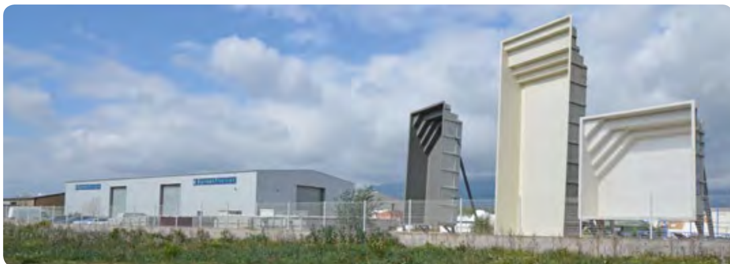
5 000 m 2 consacrés à la fabrication et au stockage auxquels s'ajoutera un bâtiment de 400 m 2
