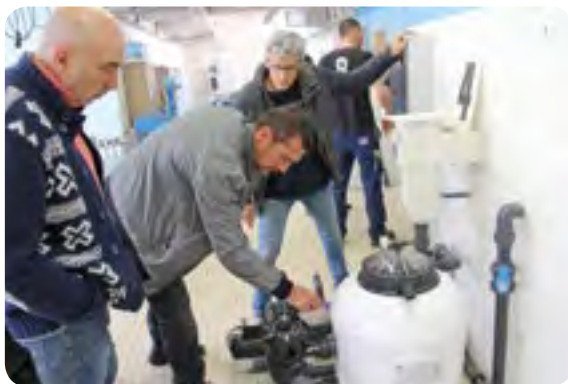
Epreuve de mise en service d'une installation de filtration
