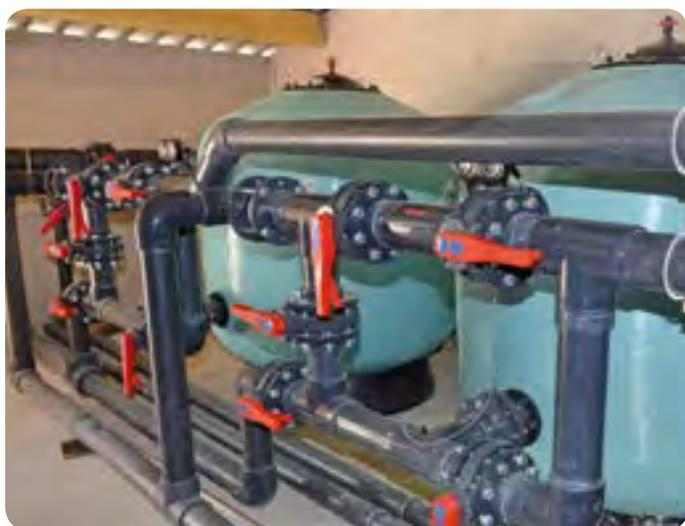
*Batterie de filtres ASTRAL avec 2 pompes de 5 CV Tri*
