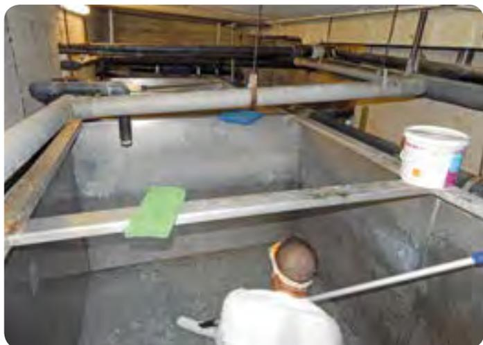
OUI : bac tampon en inox, de faible profondeur, facilité du nettoyage
