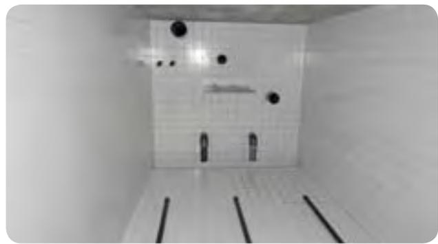
Bac tampon : on y voit bien le stripping, l'arrivée d'eau par surverse...
