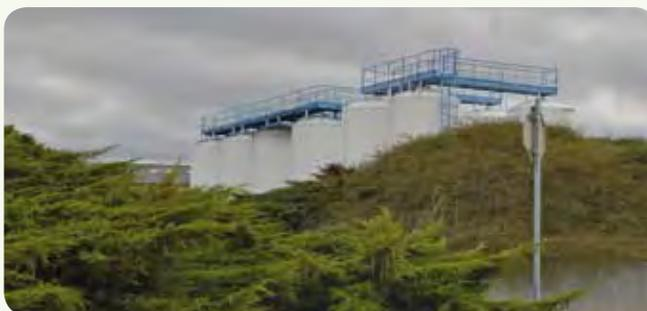
*Le « bunker » anti-incendie, protégé par des merlons de terre, dans lequel se réfugier en cas d'explosion ou d'incendie. De l'intérieur gestion et pilotage des systèmes de lutte incendie en fonction de la zone : pulvérisation d'eau, projection de mousse extinctrice...*
