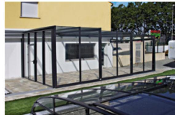
Fachleute sowie das breite Publikum waren insbesondere von der einfachen Bewegbarkeit der Segmente beeindruckt. Denn die einzelnen Teile sind extrem schwer. Das gilt für das für die Seitenwände benutzte Sicherheitsglas, das für das Dach verwendete teilvergütete Glas, das besonders solide und widerstandsfähig ist, sowie für den massiven Aluminium-Rahmen. Die positive Charaktereigenschaft wurde hauptsächlich durch die kluge Anordnung der Schienen und anderer Teile der Einfassung erreicht.
