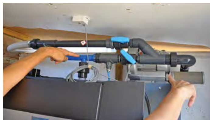
Un système de sécurité aspire l'hydrogène dégagé par un système de venturi.
