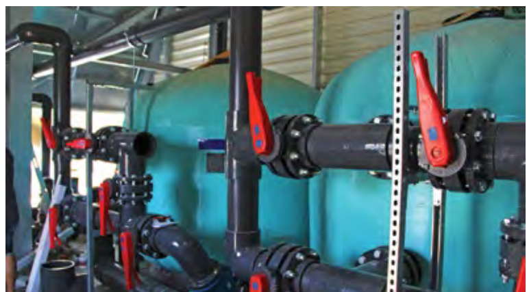
Le local technique de l'espace aquatique
