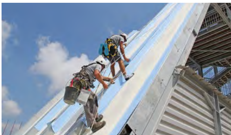
Pose du PVC Xtreme en rappel sur les 4 toboggans Water Jump
