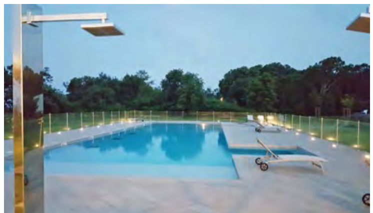
Installation du générateur de chlore in-situ Syclope au camping Casa E Natura en Corse
