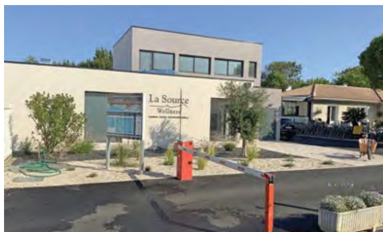
Entrée du nouveau bâtiment accueillant l'espace forme
