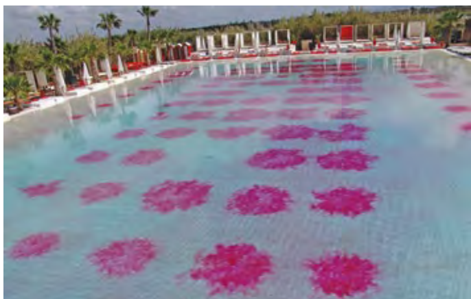
Le colorant Aquacoleur, ici utilisé pour mettre en évidence les défauts d'hydraulicités d'un bassin. Les zones claires en défaut sont immédiatement repérées.
