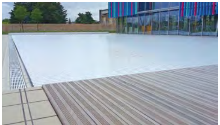
Bassin de 12,5 x 25 m à Joué-lès-Tours
