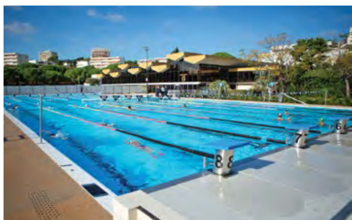
La destruction de la fosse à plonger a permis la reconstruction d'un bassin olympique avec le procédé développé par Myrtha Pools et débordement périphérique.
