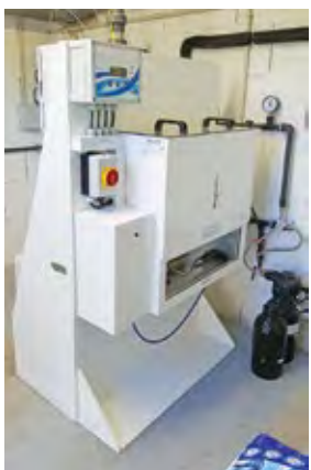
Installation du générateur de chlore in-situ Syclope à la Piscine Municipale de Billère (64)
