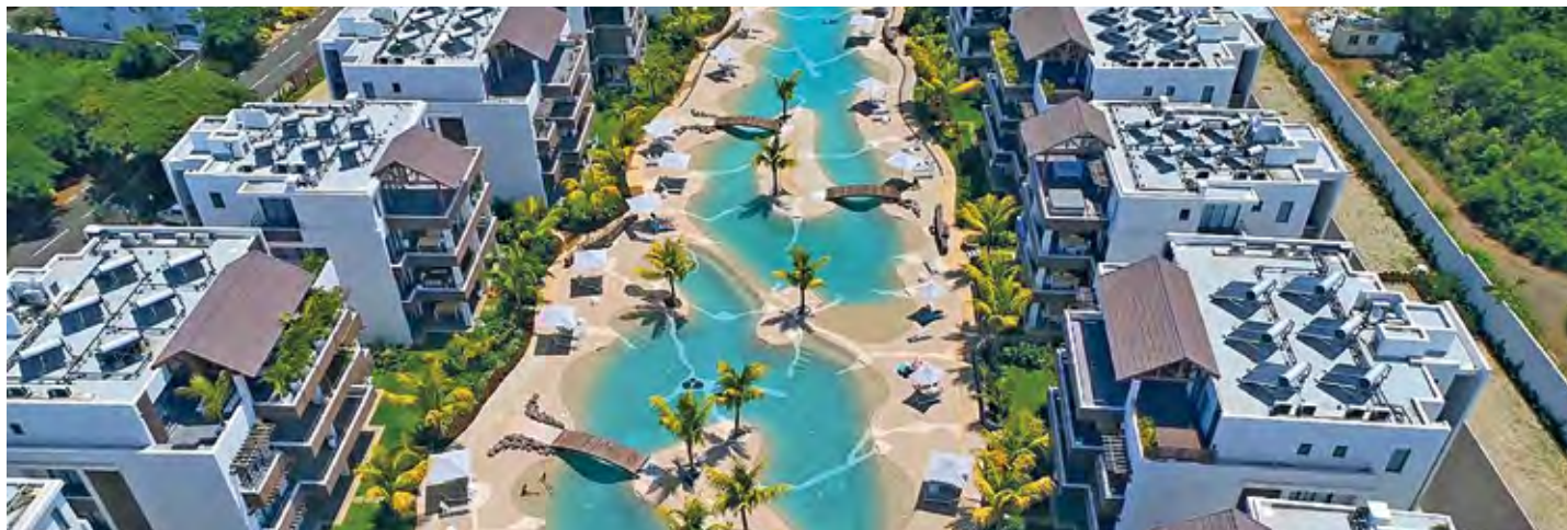
Piscine Biodesign de la Résidence Choisy-Les-Bains à l'île Maurice
