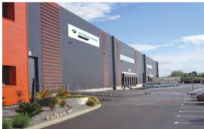
Nouvelle plateforme Logistique à Aimargues (30)
