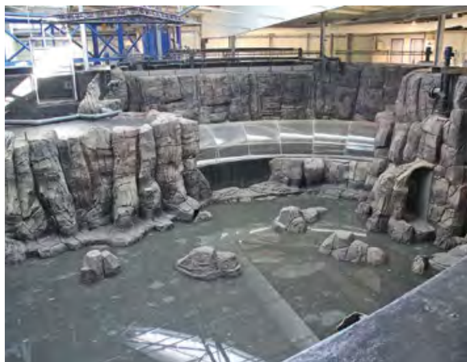
6 semaines pour le seul remplissage du Grand Bassin de 10 000 m 3 du nouveau Centre National de la Mer Nausicaá à Boulogne-sur-Mer (62).
