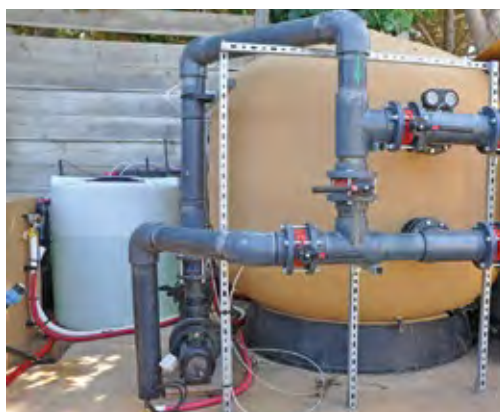
A gauche, le réservoir translucide est celui du chlore produit par le Pure Chlore®. Il est ensuite injecté dans les différents espaces aquatiques.
