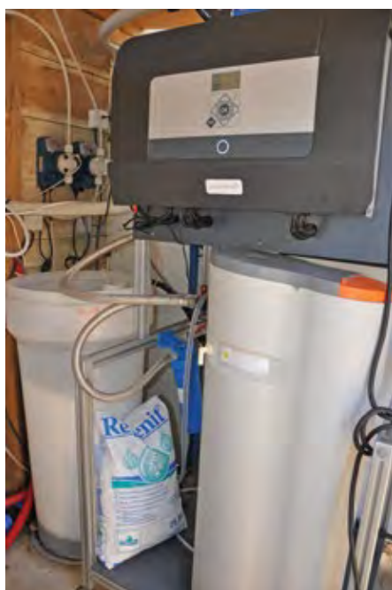
A gauche de l'appareil, le réservoir de sel, à droite, l'adoucisseur en entrée du Pure Chlore®
