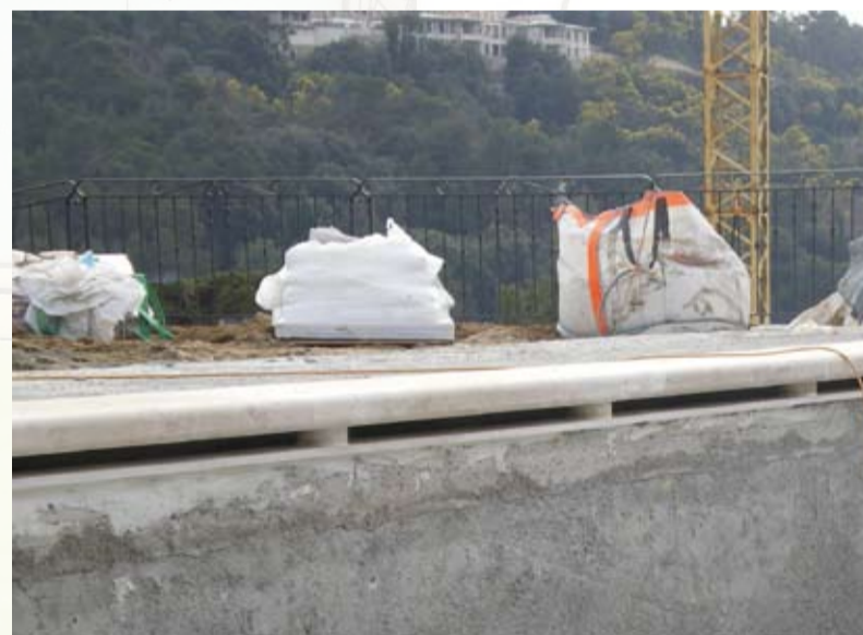
Vue du débordement sous margelle
