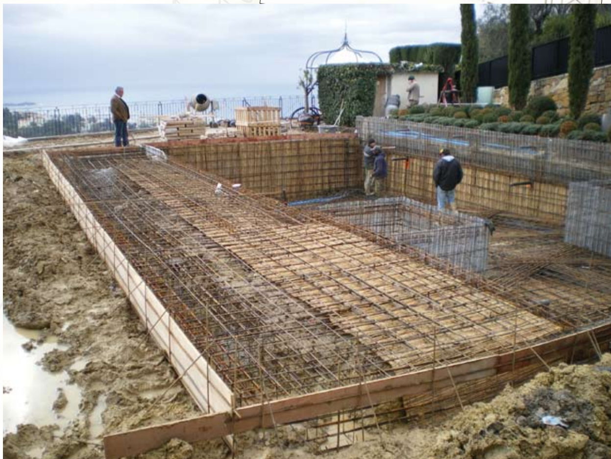
Un imposant et solide ferrailage avec système de nettoyage intégré Diffaclean
