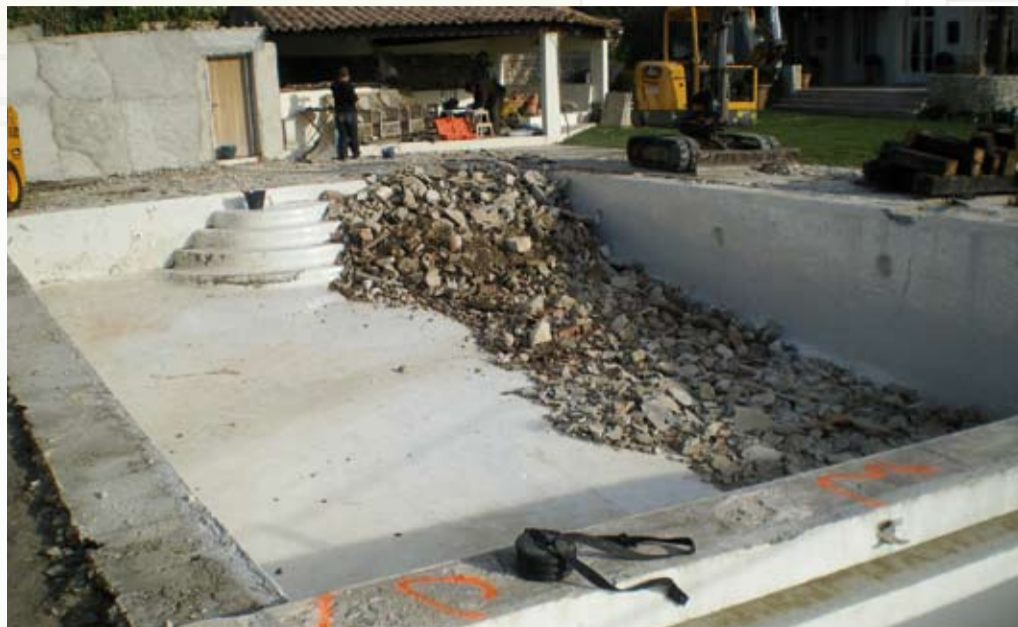
Le bassin original avec son escalier d'angle, en cours de démolition
