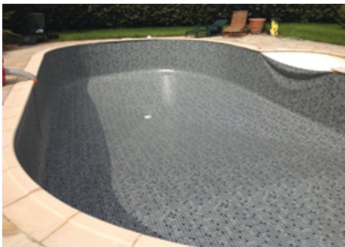
L'air emprisonné entre la structure et le liner, est aspiré par la turbine afin de bien le plaquer (**Rêves d'Eau / Océazur**)
