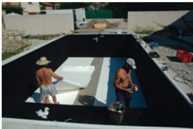
Après la mise en place du feutre de protection sur les murs en blocs de coffrage isolant polystyrène, préparation pour la pose de la membrane armée PVC 150/100° (Piscines Virginia / Ascomat)
