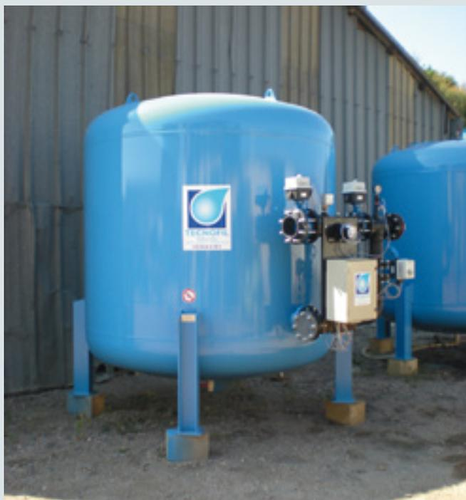
Pour la problématique des chloramines rencontrées dans les piscines couvertes, **la technique du charbon actif** est celle qui présente le meilleur spectre d'utilisation. Plus d'énergie consommée, plus de lampes à remplacer, une solution étudiée au cas par cas, installée définitivement dans le local filtration, dont les coûts d'investissement et d'exploitation sont réduits de plus de 50 %.
