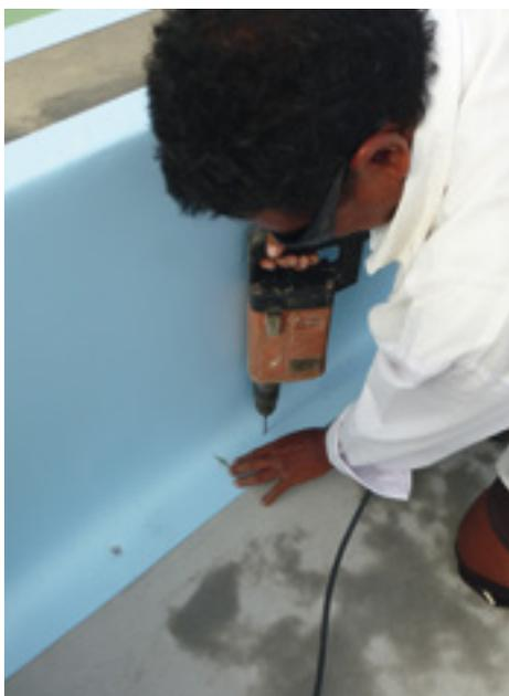
Pose de rivets spéciaux pour fixation de la membrane armée (Alkorplan)
